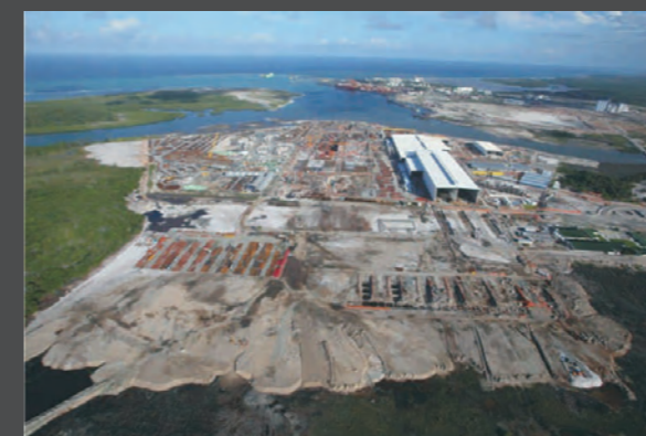
OBRAS DO ESTALEIRO ATLÂNTICO SUL, EM SUAPE - PE
